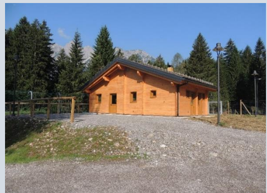
Figura 27 - Area faunistica di Forni di Sopra - Fabbricato di servizio
