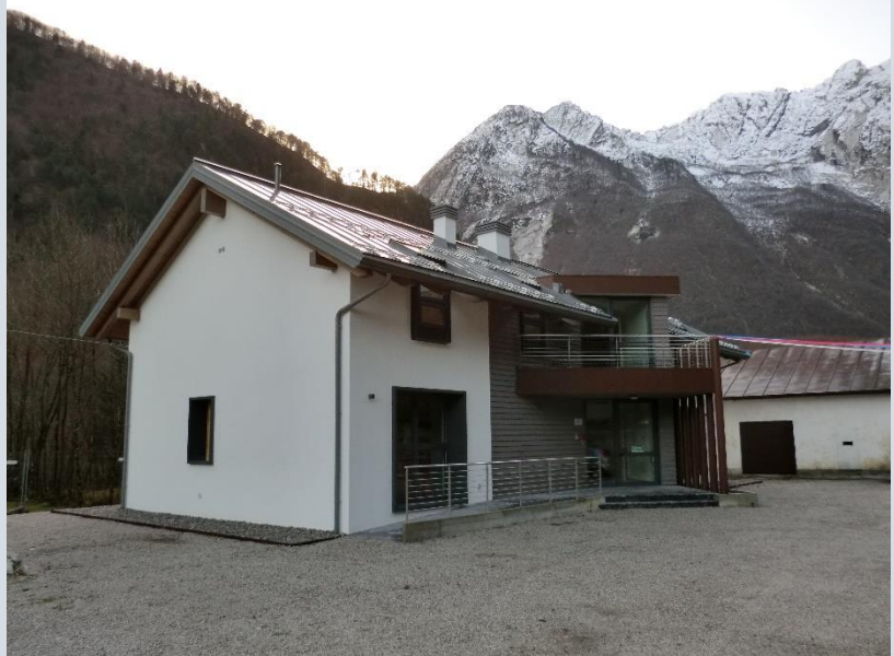
Figura 17 - Ex casermetta di Lischiazze dopo la ristrutturazione
