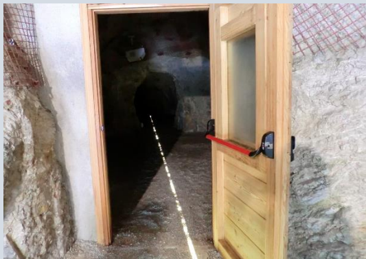
Figura 13 - Ghiacciaia di Resiutta - Ingresso parte interna
