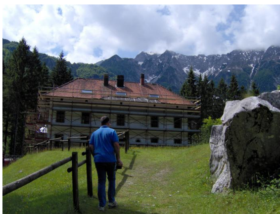
Figura 3 - Villa Emma in corso di ristrutturazione
