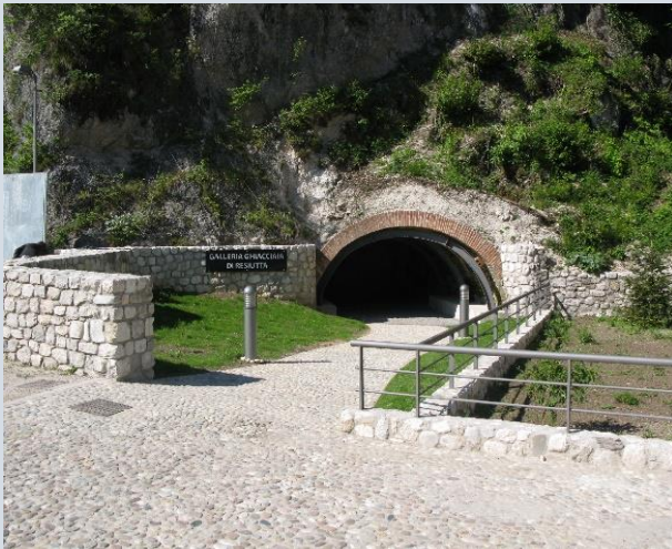
Figura 11 - Ghiacciaia di Resiutta - Vista esterna
