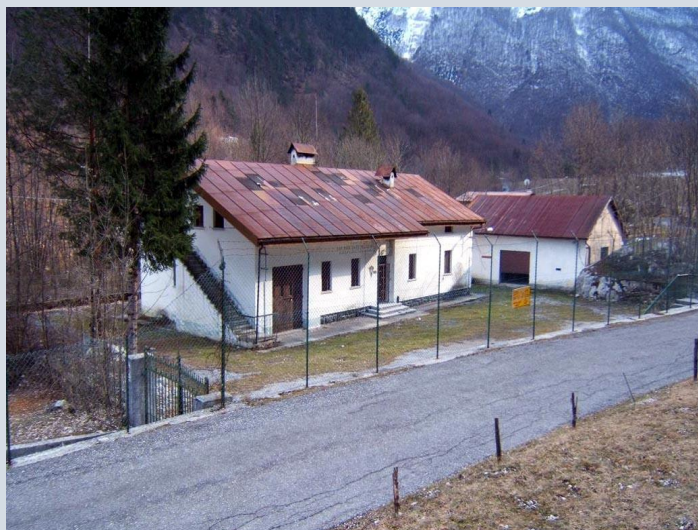
Figura 16 - Ex casermetta di Lischiazze prima della ristrutturazione
