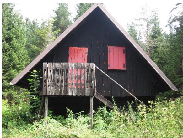
Figura 5 - Baita Mesule prima della ristrutturazione
