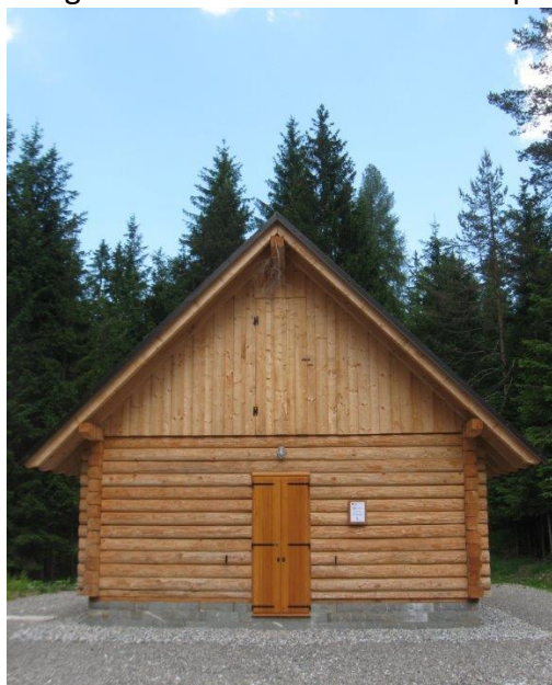
Figura 7 - Baita Mesule a lavori ultimati
