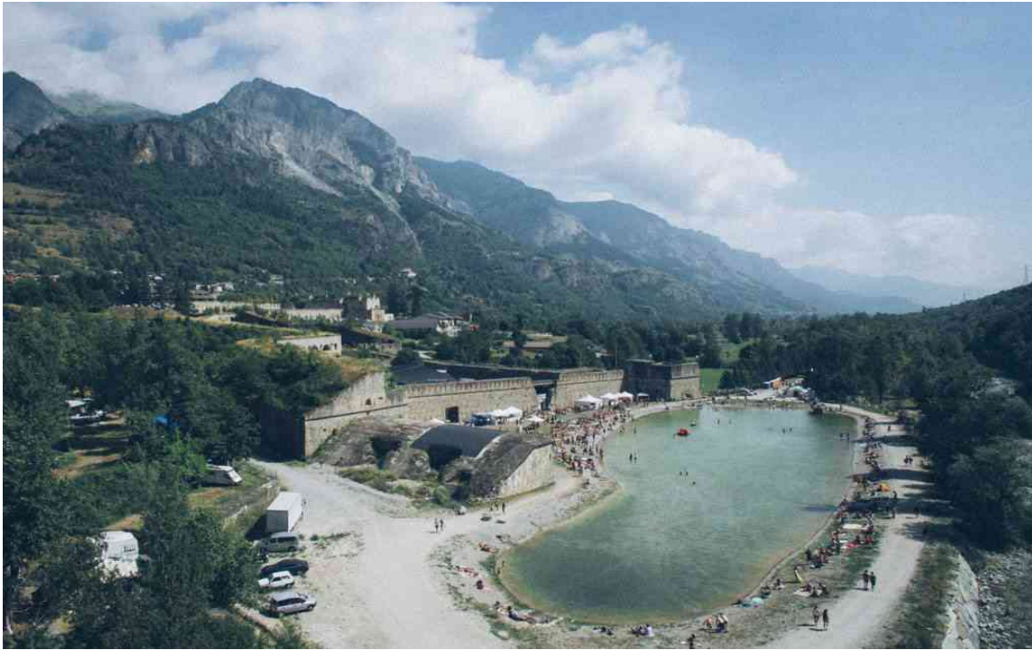
Fig. 1.3 - Plan d'eau realizzato presso Vinadio, alimentato con le acque del Fiume Stura di Demonte.
