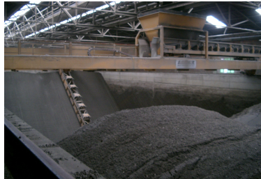
Fig. 5 - Silo di stoccaggio
