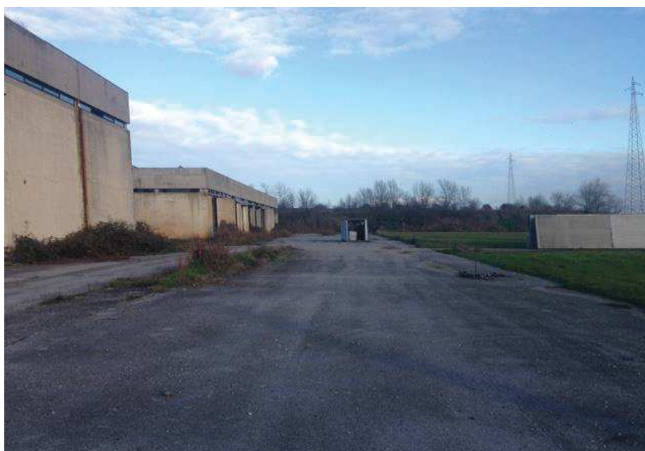
Fig.3 - Vista da Ovest delle strutture esistenti (foto scattata il 27.12.2019).
