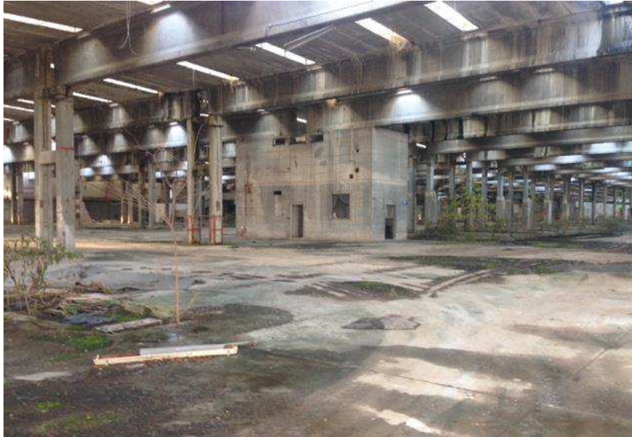
Fig.4 - Immagine dell'interno del primo edificio (estremità Sud dell'area; foto scattata il 27.12.2019).
