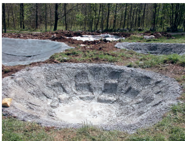
Impermeabilizzazione delle pozze a Plan di Tapou (Lusevera, Udine), visione d'insieme.
