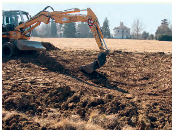
Operazione di rifinitura del fondo delle pozze con terra di riporto.
