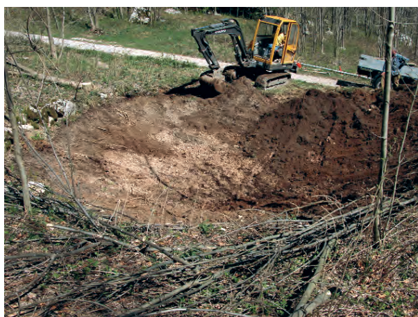
Scavo delle pozze a Plan di Tapou (Lusevera, Udine), particolare.
