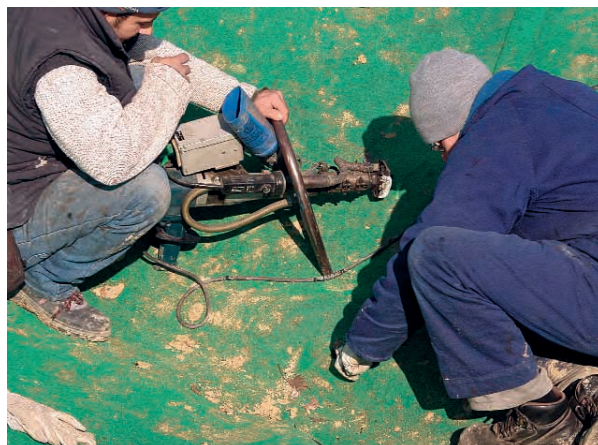
Le varie fasi di stesura, sovrapposizione e sutura dei lembi del telo in polietilene "HPDE" sul fondo del Bacino N. 2.
