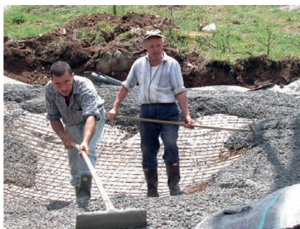
Rifiniture dell'armatura del cemento sul fondo delle pozze a Plan di Tapou (Lusevera, Udine).
