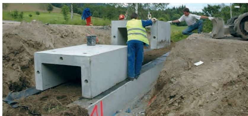
Installazione di un sottopasso per piccoli animali sull'AW 103 (stagno Repnik, maggio 2006). Einrichtung einer Unterführung für Kleintiere an der AW 103 (Repnik-Teichs, Mai 2006). Installation of an underpass for small animals on the AW 103 (Repnik pond, May 2006).
