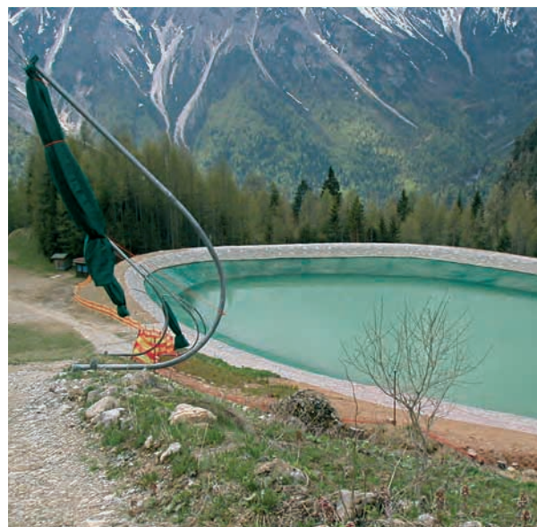
Diverse raccolte d'acqua artificiali vengono utilizzate da anfibi in riproduzione, ma le pareti di questi bacini, troppo lisce e inclinate, creano loro grosse difficoltà. Nell'immagine la vasca che serve agli impianti di innevamento artificiale in loc. Varmost (Forni di Sopra, Udine) [da 318].
