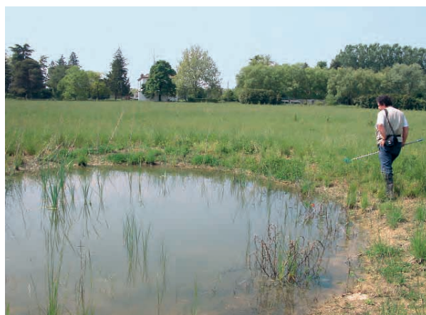
Aspetto finito del Bacino N. 1 impermeabilizzato con il "Bentomat" dopo un anno dall'intervento.
