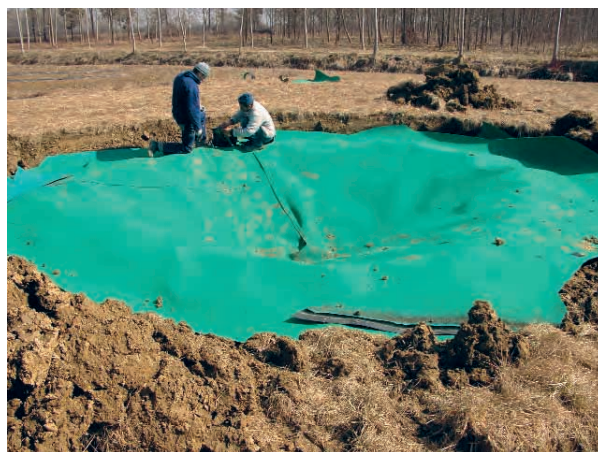
Lo scavo di una delle pozze all'Azienda Volpares (Palazzolo dello Stella, Udine) prima dell'impermeabilizzazione.
