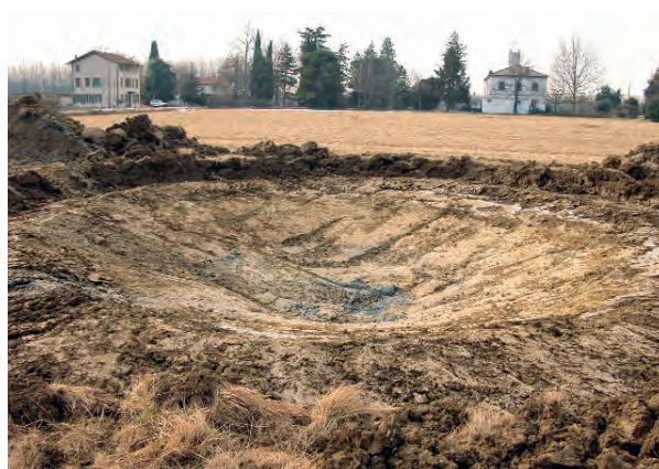
Lo scavo di una delle pozze all'Azienda Volpares (Palazzolo dello Stella, Udine) prima dell'impermeabilizzazione.
