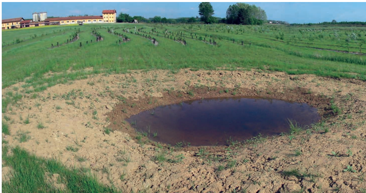
Il Bacino N. 1 con fondo impermeabilizzato con "Bentomat" ad allestimento concluso; sullo sfondo l'Azienda Volpares con i ripristini ambientali effettuati dall'Ufficio studi faunistici.
