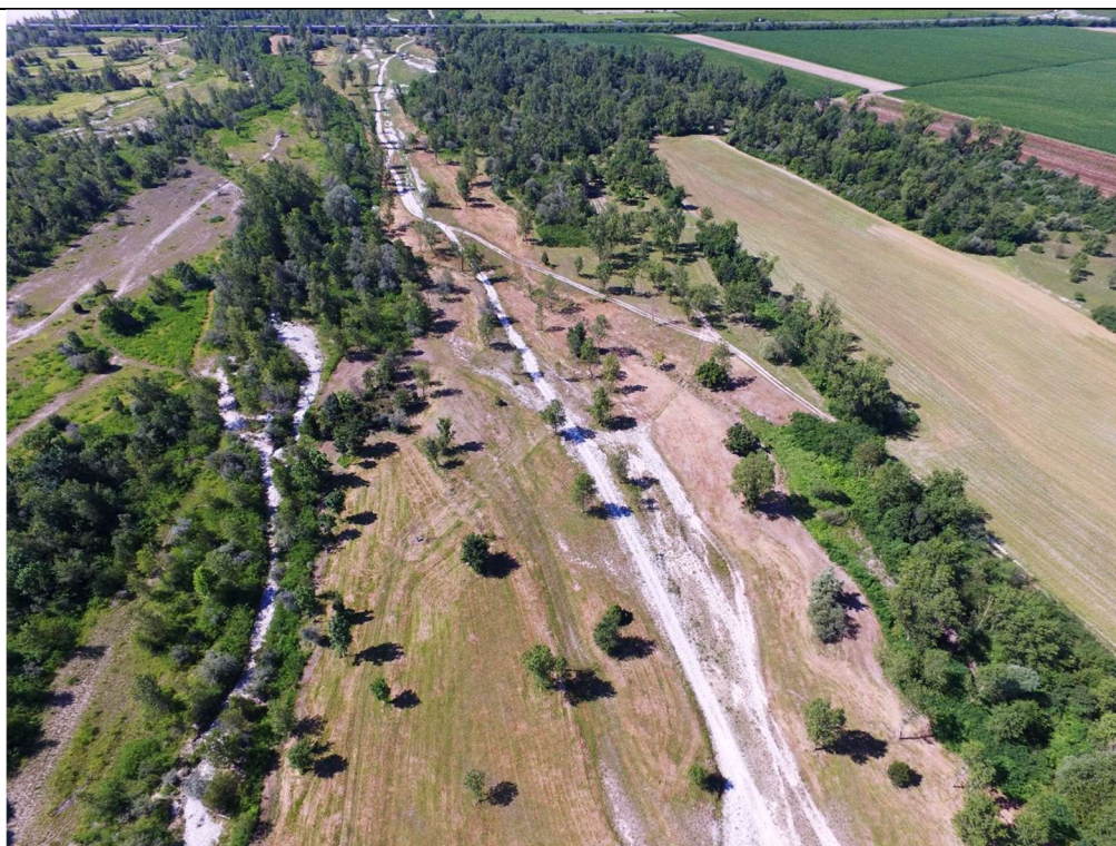
Drone: area della golena del Tagliamento in Comune di Spilimbergo, adiacente al ponte sulla strada statale. Visione ravvicinata degli interventi di decespugliamento effettuati.
