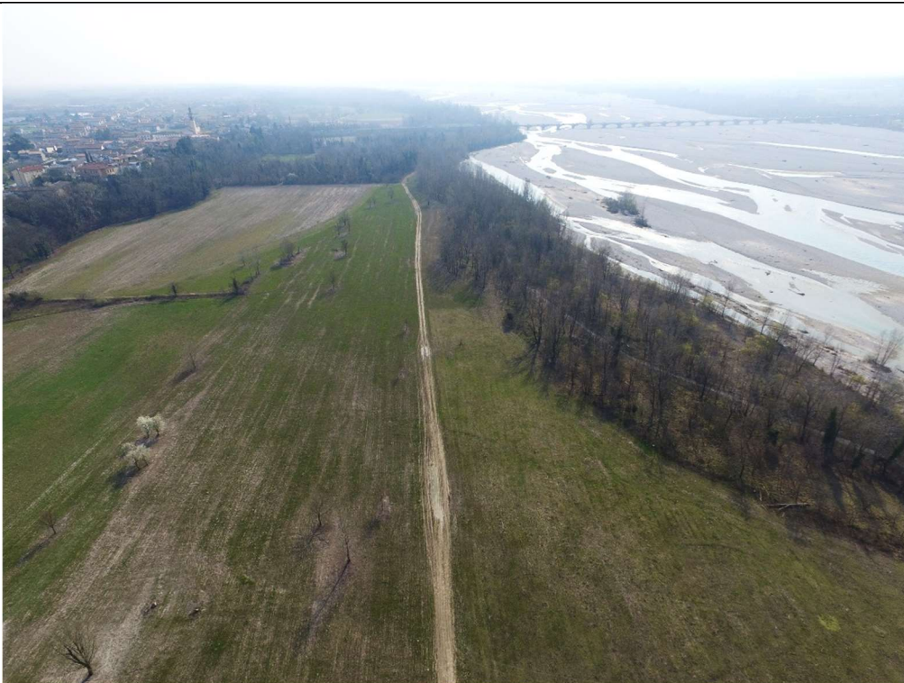
Drone: area in sponda sinistra del firme Tagliamento nei pressi di Dignano dopo gli interventi del progetto LIFE. A sinistra della strada vi è l'area di monitoraggio 31a, a destra la 31b.
