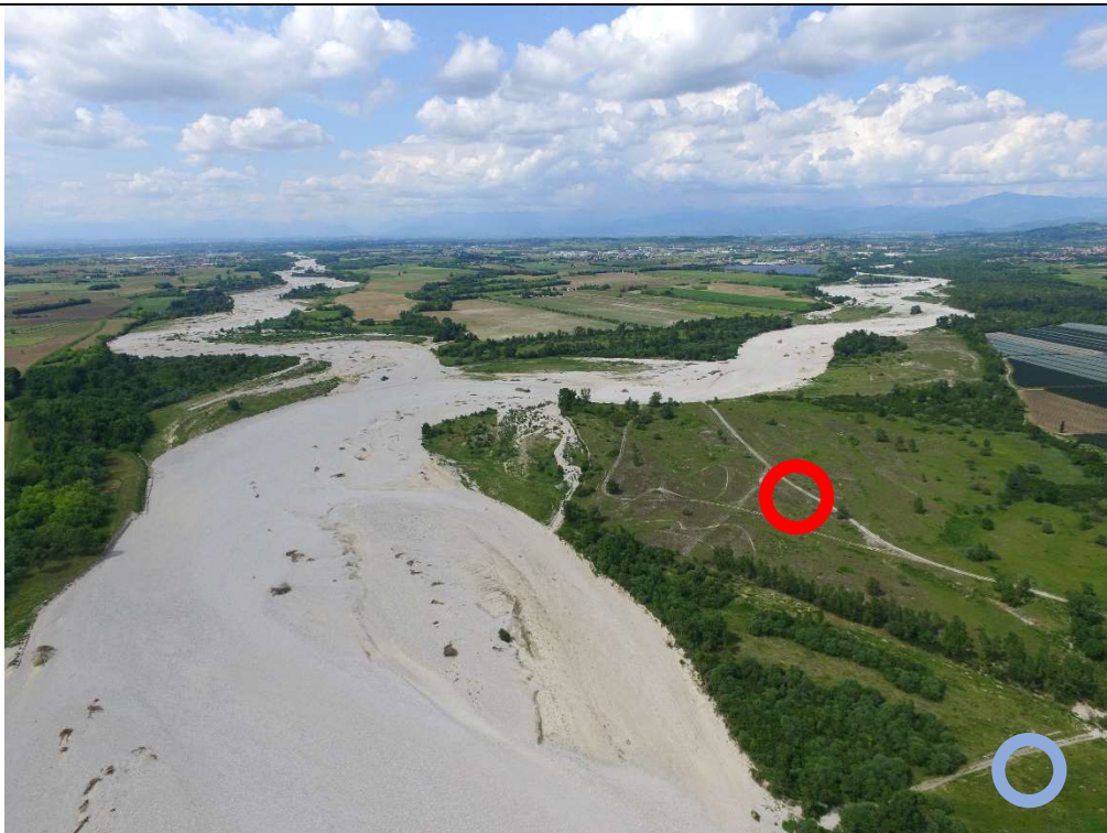
Drone: area a valle della confluenza dopo gli interventi di miglioramento
