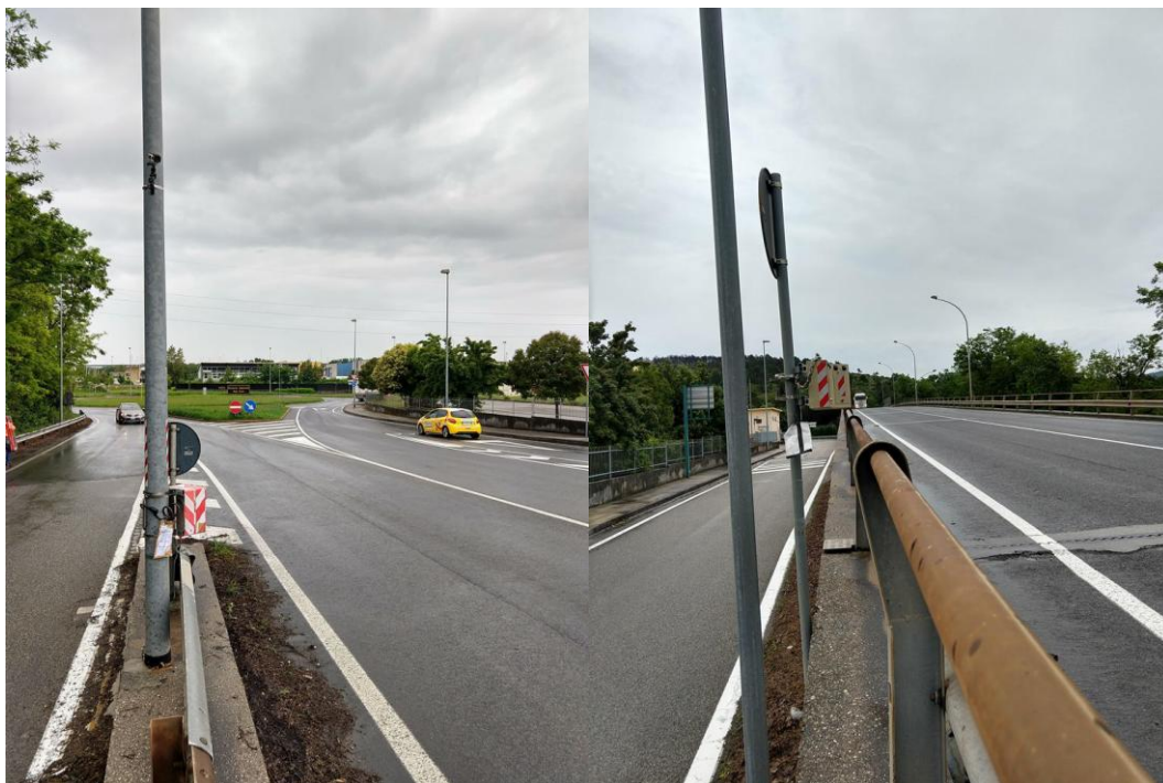
Figura 10 – Sezione R01 – Installazione strumentazione in direzione A e B rispettivamente
