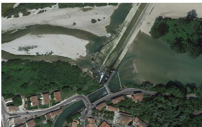
Figura 3.6 - opera di presa sull'Isonzo
