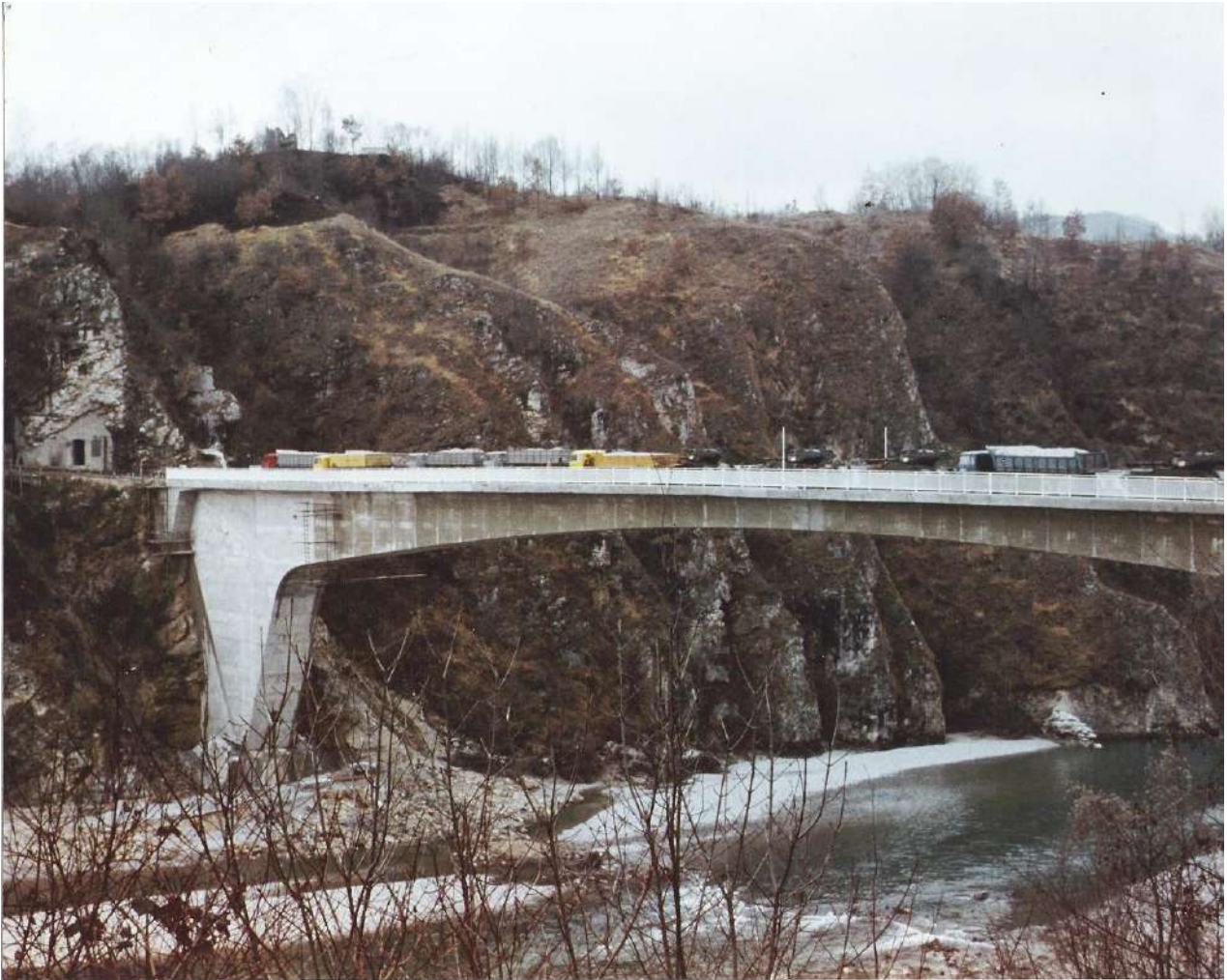
Il ponte durante il collaudo del 1969 con camion e carri armati dell'esercito
