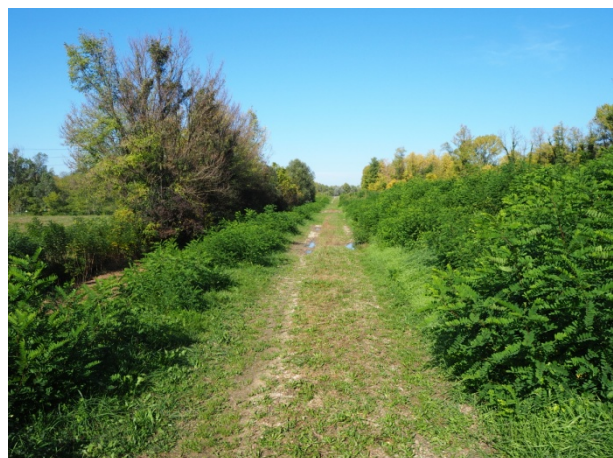
L'argine del Torrente Torre
