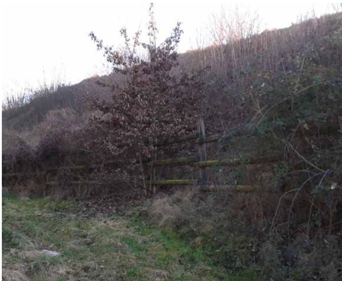
8. I resti del poderoso terrapieno settentrionale (lato nord) ricoperto da fitta vegetazione spontanea e delimitato da recinzione in legno.
