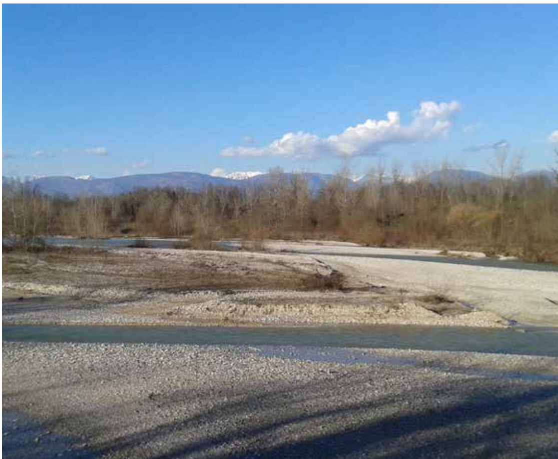
4. Il torrente Cosa ripreso dal ponte esistente lungo la strada Spilimbergo-Casarsa.
