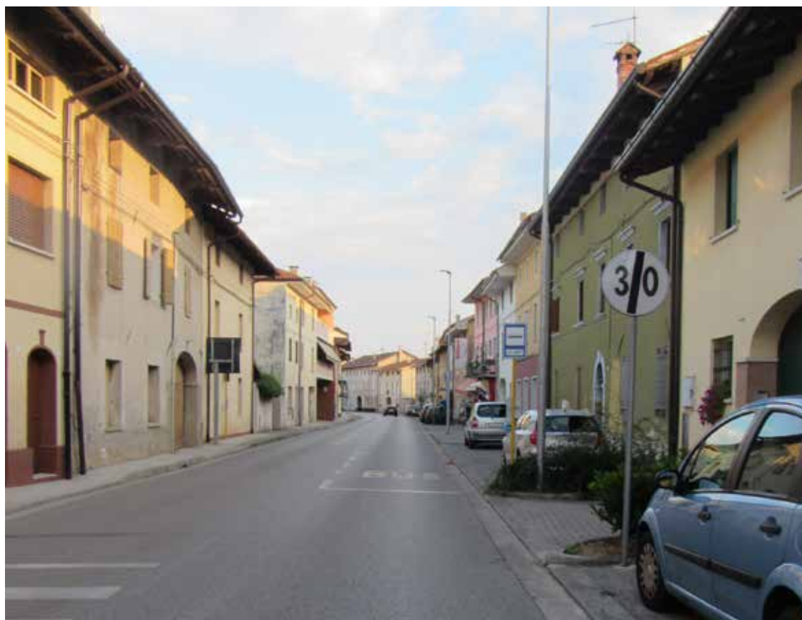
5. Gradisca di Sedegliano. Il cardine passante per il paese ripreso da nord verso sud (via Massimo d'Azeglio).
