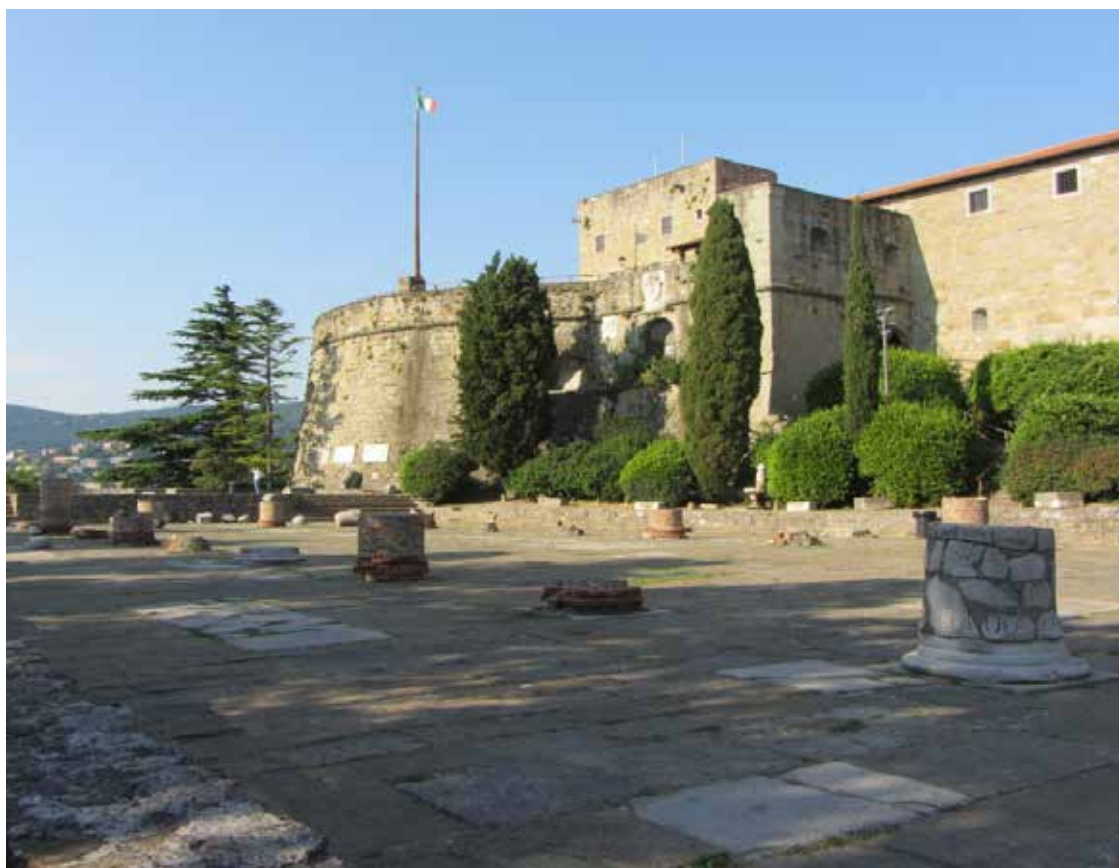
16. I resti della basilica civile, edificio diviso in tre navate da due file di colonne in calcare d'Aurisina.
