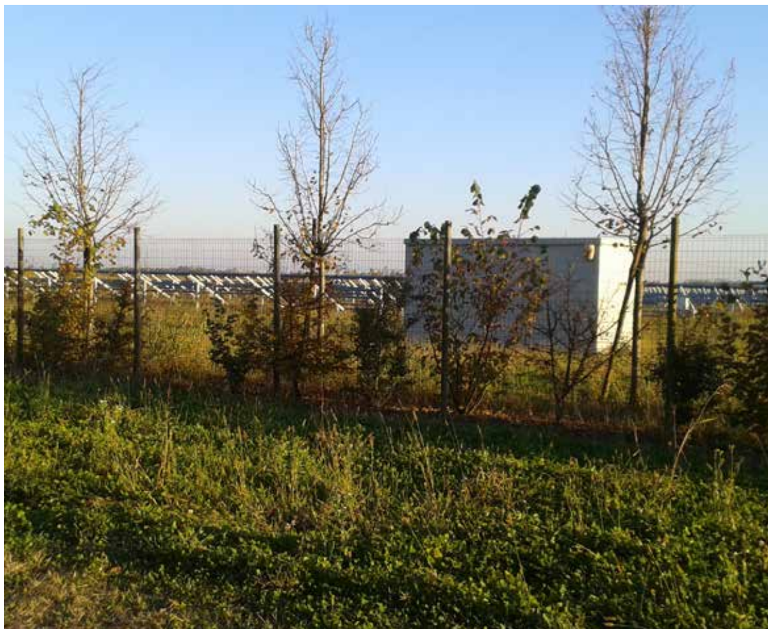
8. A sud dell'area boschiva, oltre la strada bianca, è stato impiantato in anni recenti un impianto fotovoltaico.
