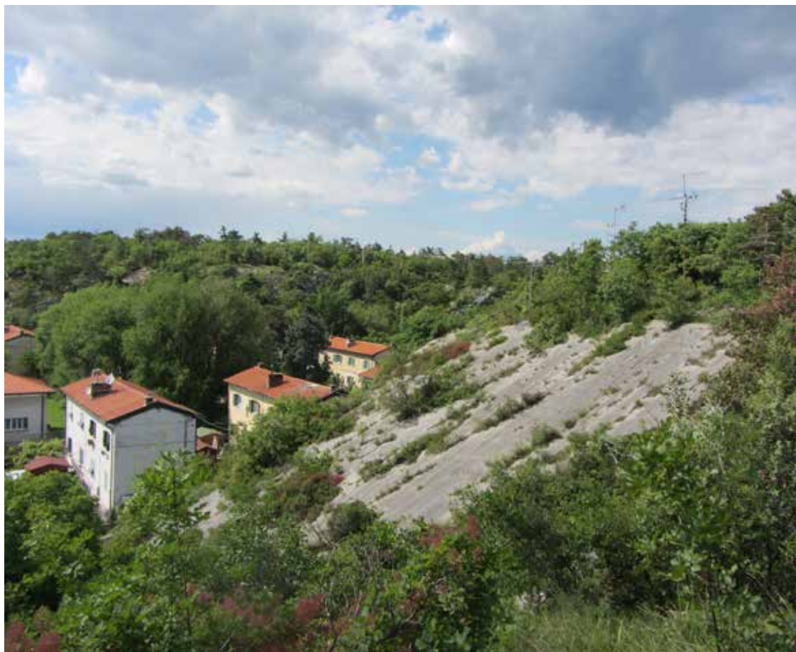
4. Il costone roccioso alle spalle del Villaggio del Pescatore come si presenta oggi.
