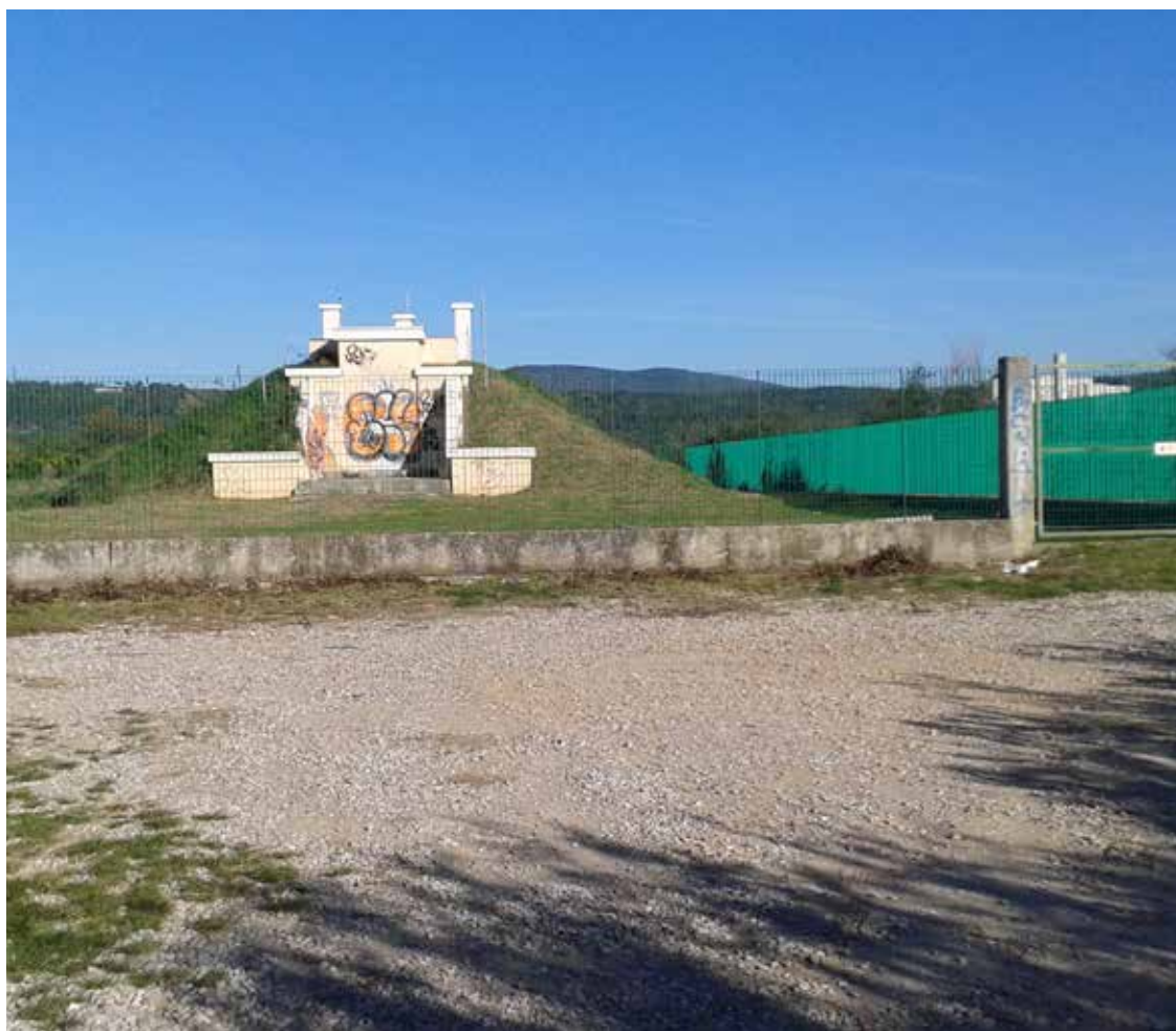
3. La sommità del colle occupata da un serbatoio dell'acquedotto comunale.
