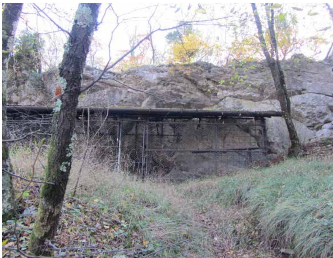
3. L'attuale sistemazione del riparo sotto roccia: una tettoia e una recinzione metallica delimitano il bene.
