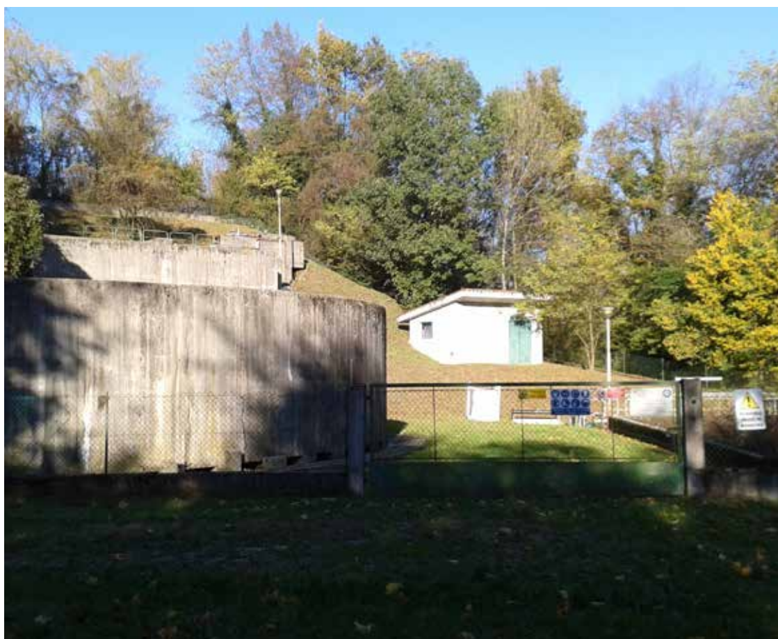
8. L'acquedotto Poiana alla base del terrazzo proteso sull'Alberone (da ovest verso est).
