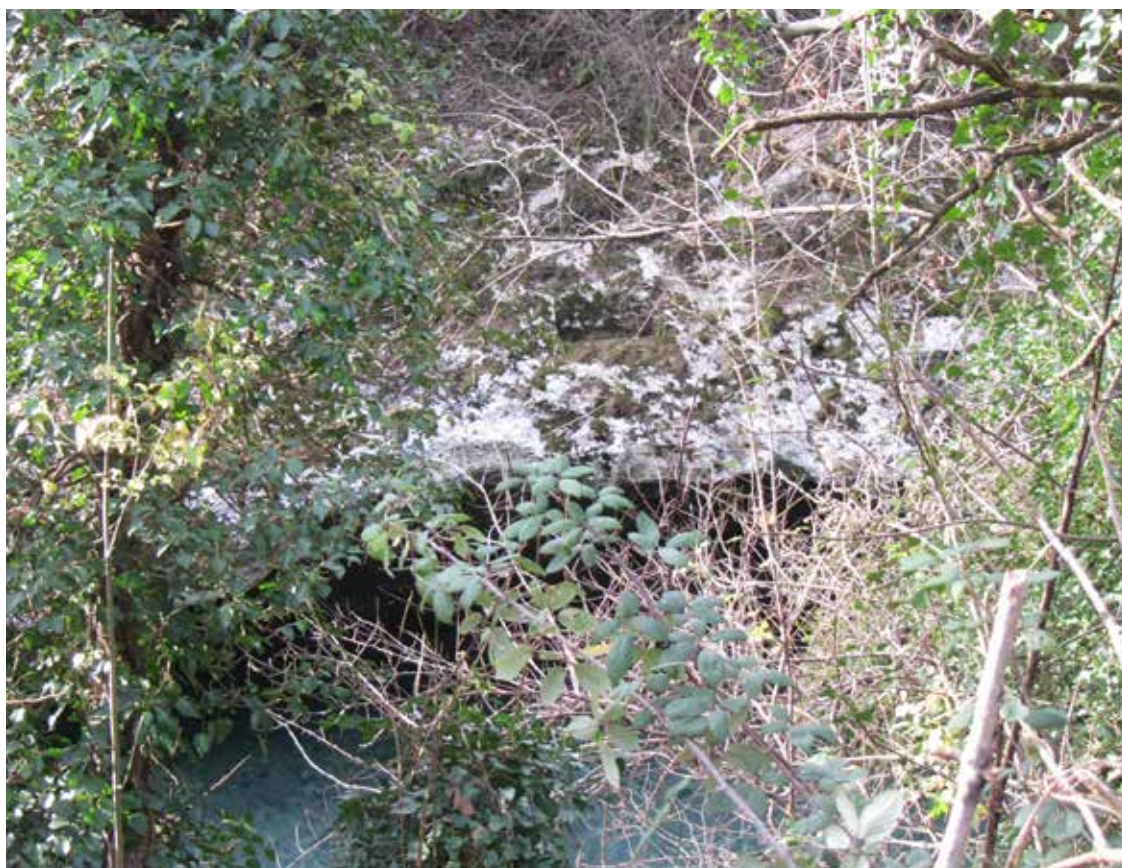
5. Nella fitta boscaglia è riconoscibile un incasso per l'alloggiamento delle strutture di sostegno del ponte romano (sponda destra).
