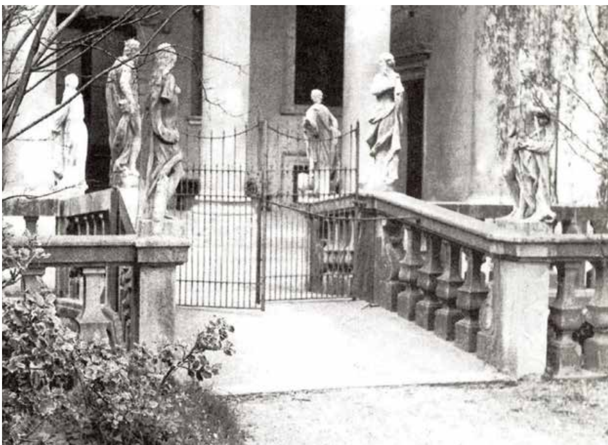
il ponticello sulla roggia che collega palazzo e giardino, IPAC
