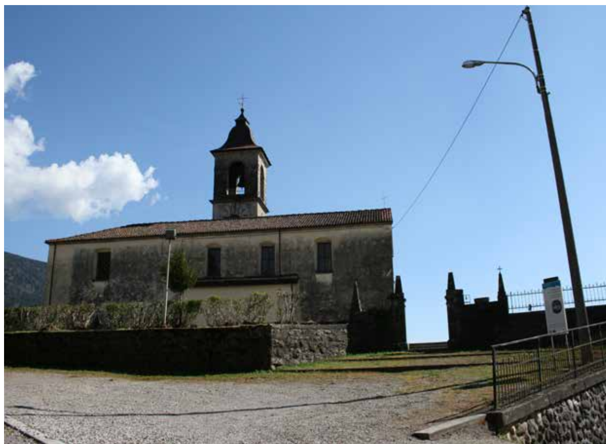
accesso all'area della pieve – IMG_1389
