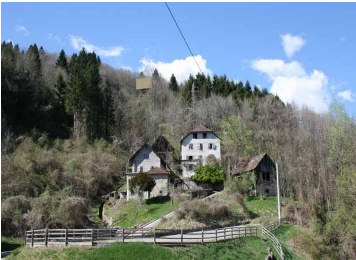
Nucleo rurale nei pressi della chiesa di San Giorgio. In alto impatto visivo del ripetitore di recente collocazione – IMG_1302
