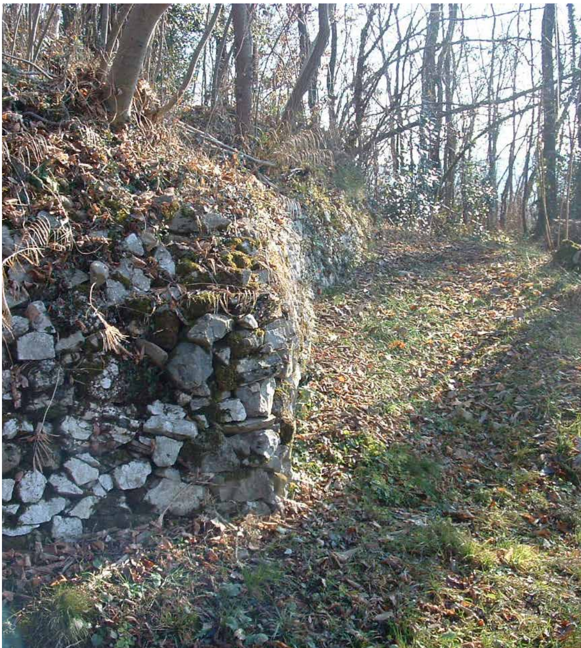
Artegna, Borgo Sotto Monte, terrazzamenti con muri a secco (Foto di A. Triches)
